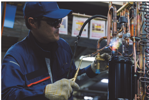
管のロウ付け※：複雑で繊細な作業
